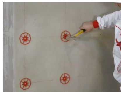
Obr. 37 – Aktivace kotvy StarTrack Red
