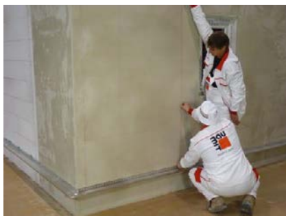
Obr. 35 – Vyznačení rastru
