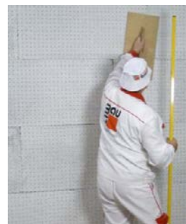
Obr. 21 – Broušení fasádních desek
