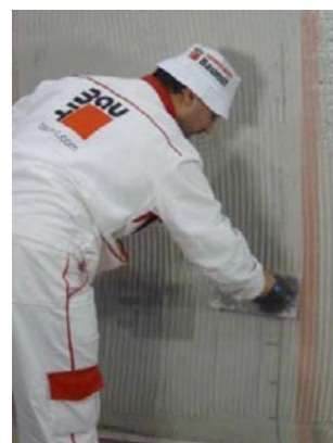
Obr. 30 – Dodatečné vyztužení
