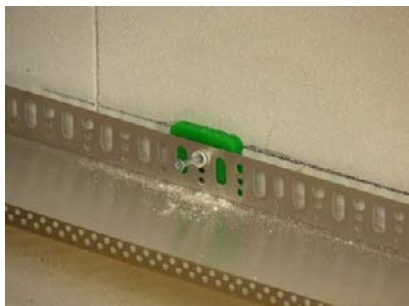
Obr. 13- Soklová distanční podložka
