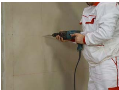
Obr. 36 – Vrtání otvorů pro kotvy
