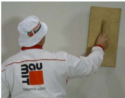
Obr. 32 – Broušení základní vrstvy
